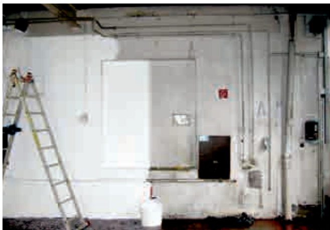
Het aanbrengen van één verflaag in een garage
